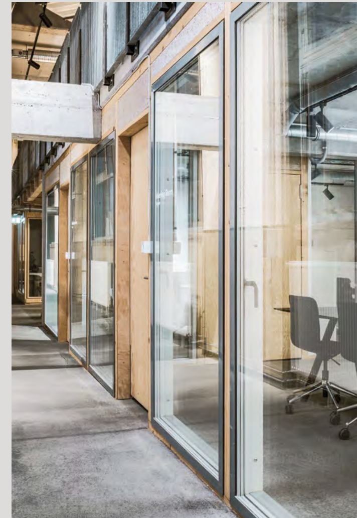
ABB. 12 Gebrauchte, doppelt verglaste Fenster werden als Trennwände zwischen Flur und einzelnen Besprechungsräumen verwendet.
