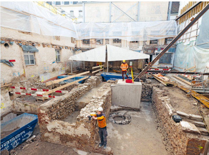
ABB. 11 Der gut erhaltene Kellerboden von «Hiltmars Hus» ist im Vordergrund rechts zu sehen, unter den beiden nachmaligen Häusern «Storchen» und «Helfenstein». Die dicke weisse Begrenzungsmauer links gehört zum ursprünglichen Bau des 13. Jhs., die schmale, rötlich verbrannte rechts stammt von der späteren Haustrennung. Foto: Philippe Saurbeck.
